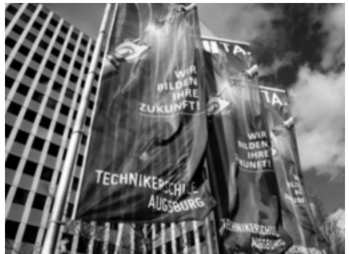
Das Schulgebäude in Augsburg-Haunstetten. (Bild: Technikerschule Augsburg)
