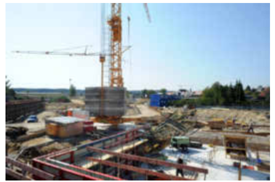
Eine logistische Meisterleistung. Wasserhaltung und Verbau sorgen für die reibungslosen Betonarbeiten der Keller und Tiefgarage.
