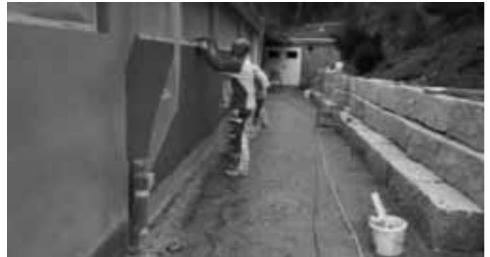
Freibad - Maler- und Putzarbeiten
