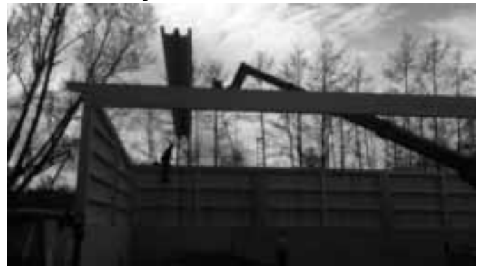
Kalthalle im Bauhof - Wände und Dach
