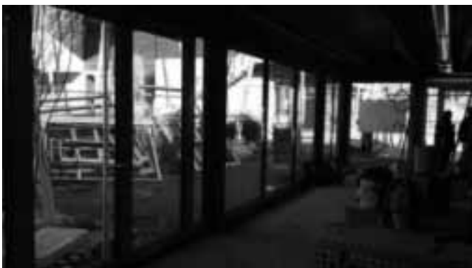
Türen und Fenster im Foyer
