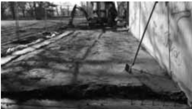
Fundament für Lüftung im Umkleidebereich
