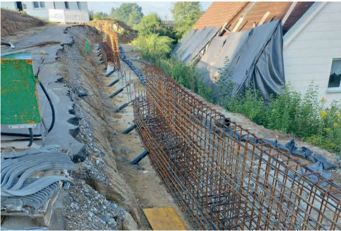
Herstellung des oberen Teils des Pfahlkopfbalkens auf den Bohrpfählen
